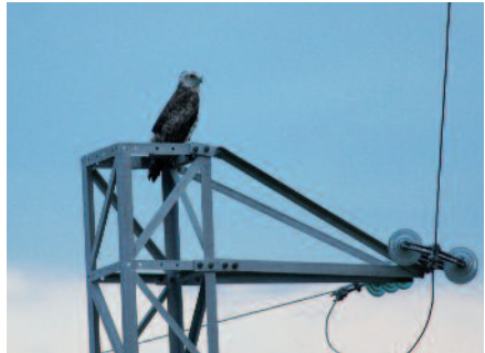
Àliga marcenca ( Circaetus gallicus ) aturada sobre un suport d'una línia elèctrica, al Barranc de l'Infern, Vilajuïga. 11 d'agost de 2009. Autor: Ponç Feliu.
